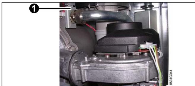
▶ Desserrer les 4 vis de maintien du corps de chauffe ❶
